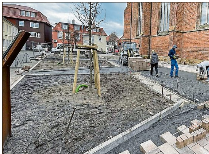
Es muss einiges gepflastert werden: Die Umgestaltung des Kirchplatzes nimmt Form an. Foto: Stadt Dinklage / Miosga
