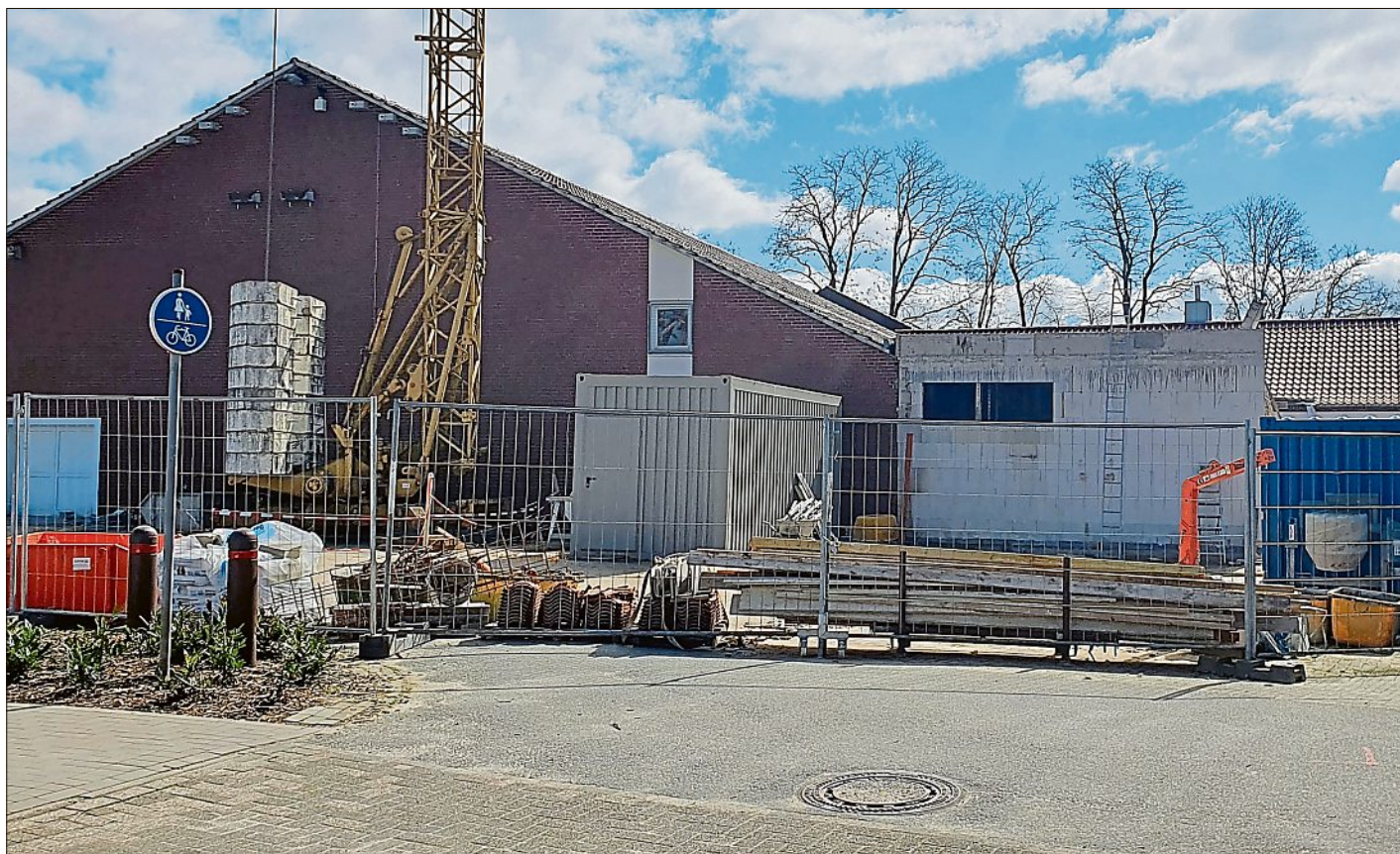
Wird innen saniert und außen erweitert: Die Sporthalle an der Kardinal-von-Galen-Schule.
